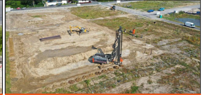
1.000 m unverrohrte Trägerbohrung Alanbrooke Quartiere, Paderborn
