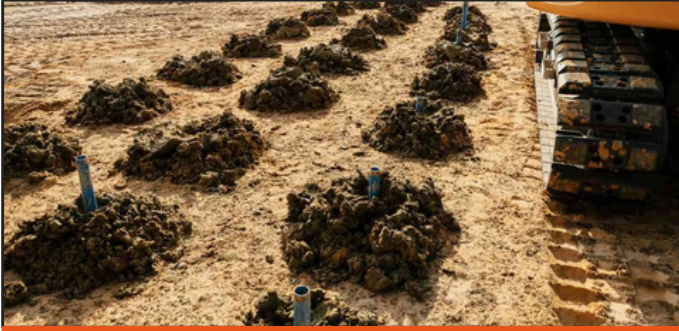
1.000 Sondierungsbohrungen Rentforter Straße, Bottrop
