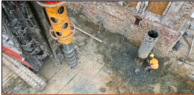
575 m Bohrpfähle als Gründungspfähle Humboldtstraße 6, Dortmund
