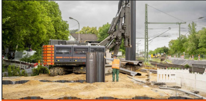
1.300 qm Spundwand Bröltalbahnhof, Bonn
